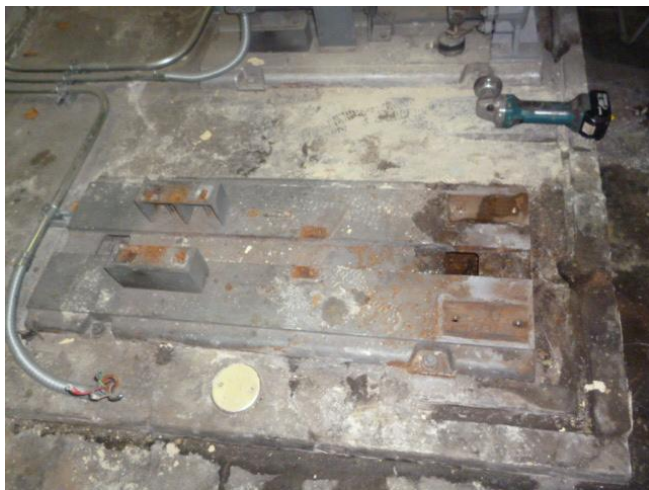
ポンプ、モータ 撤去後
